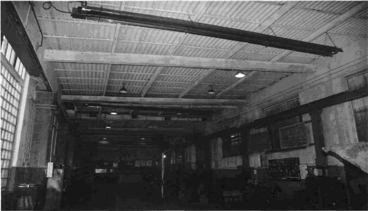
Опалення ремонтних цехів за допомогою інфрачервоних випромінювачів у вагонному депо Жмеринка
