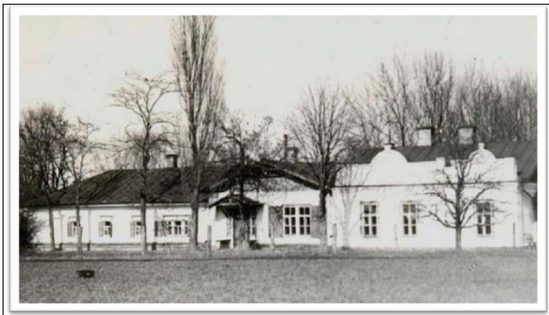
Адміністративна будівля Полтавського дослідного поля
