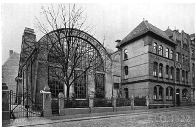
Рис. 5 – Електростанція у районі Лінден, Ганновер, 1922 р. [17]
